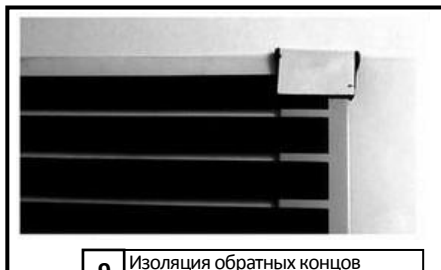
9 Изоляция обратных концов медных проводников
