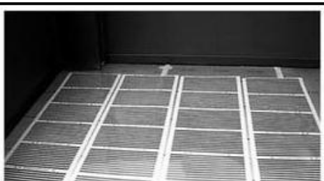
6 На теплоизоляционный материал настиляется нагревательная пленка
